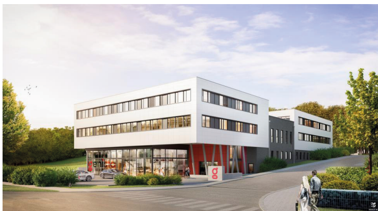
Photo 1 : Futur bâtiment sis à 1, op den Leemen à Fentange
